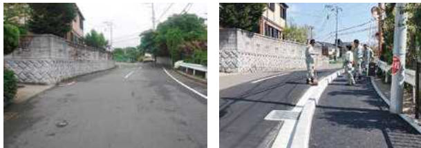
▲下山口「白石橋」付近の都市計画道路 (左が着工前・右が工事後の歩道)
